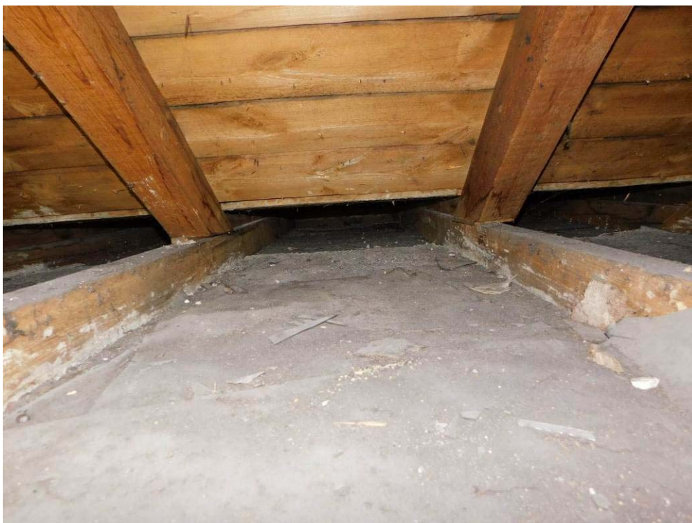
Foto 7.22. – Celkový pohled na charakter konstrukce krovu (úroveň 4.NP) – bez viditelných poruch či koroze dřeva
