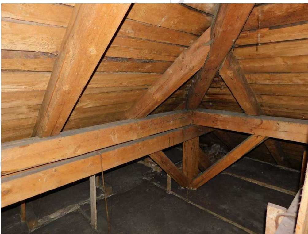
Foto 7.29. – Celkový pohled na charakter konstrukce krovu (úroveň 4.NP) – bez viditelných poruch či koroze dřeva
