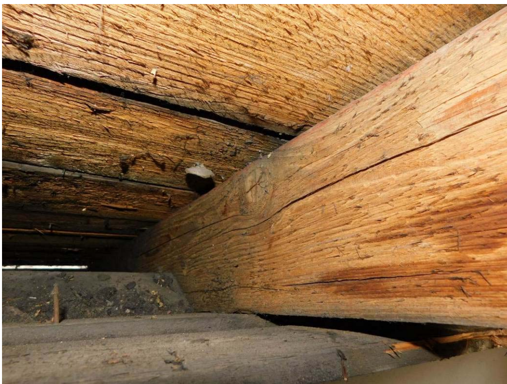
Foto 7.20. – Sonda K6 (úroveň 3.NP) – krokev a pozednice – bez viditelných poruch či koroze dřeva
