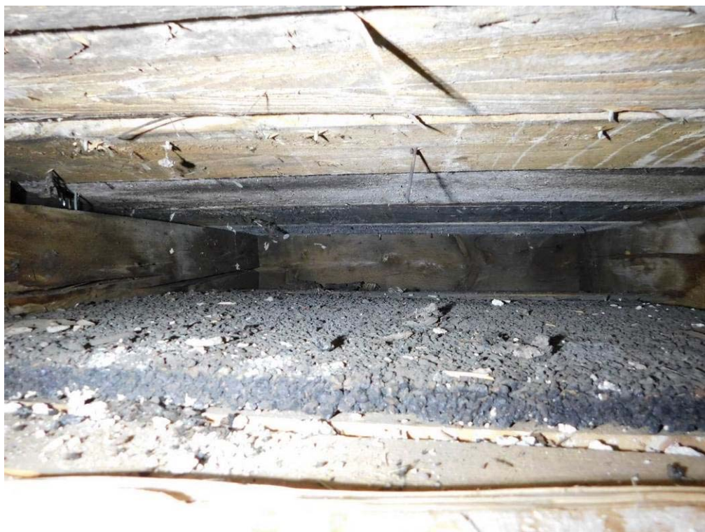
Foto 7.8. – Sonda K2 (úroveň 3.NP) – charakter konstrukce podhledu vikýře – bez viditelných poruch či koroze dřeva
