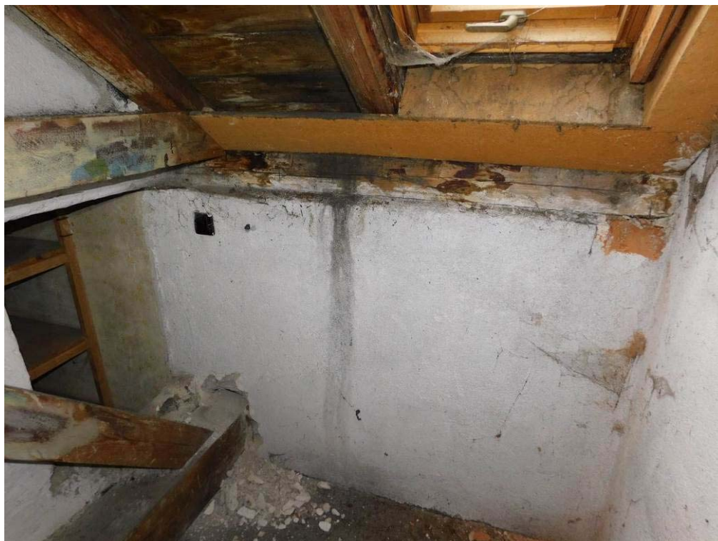
Foto 7.14. – Sonda K4 (úroveň 3.NP) – zhlaví vazného trámu – bez viditelných poruch či koroze dřeva
