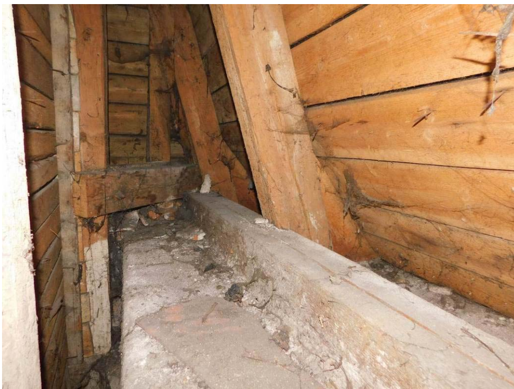
Foto 7.55. – Sonda K10 – 3.NP - pohled do dutiny za vyzdívkou – bez viditelné koroze dřeva
