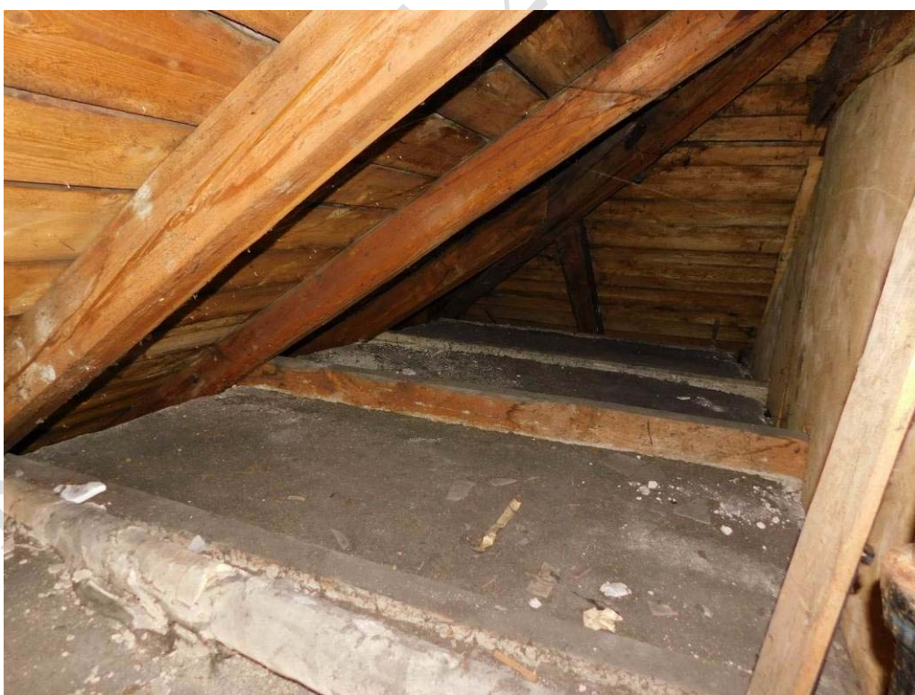
Foto 7.21. – Celkový pohled na charakter konstrukce krovu (úroveň 4.NP) – bez viditelných poruch či koroze dřeva
