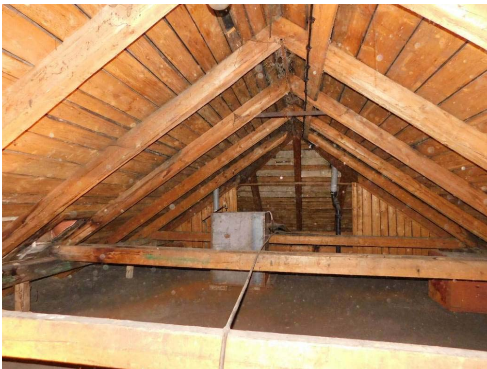
Foto 7.24. – Celkový pohled na charakter konstrukce krovu (úroveň 4.NP) – bez viditelných poruch či koroze dřeva
