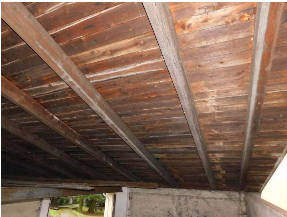
Foto 7.79. – Přístavbu na severní straně od objektu – charakter konstrukce střechy (trámky 140/95) – bez viditelné koroze dřeva
