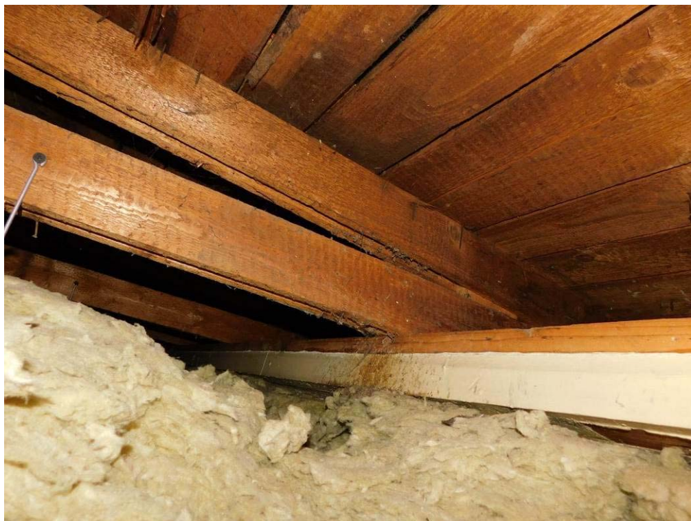
Foto 7.40. – Sonda K7 – Sonda do podhledu 2.NP – pohled na krajní vaznici, která však není ničím podepřena (pravděpodobně původní prvek), dnes nahrazen věncem z YTONGU
