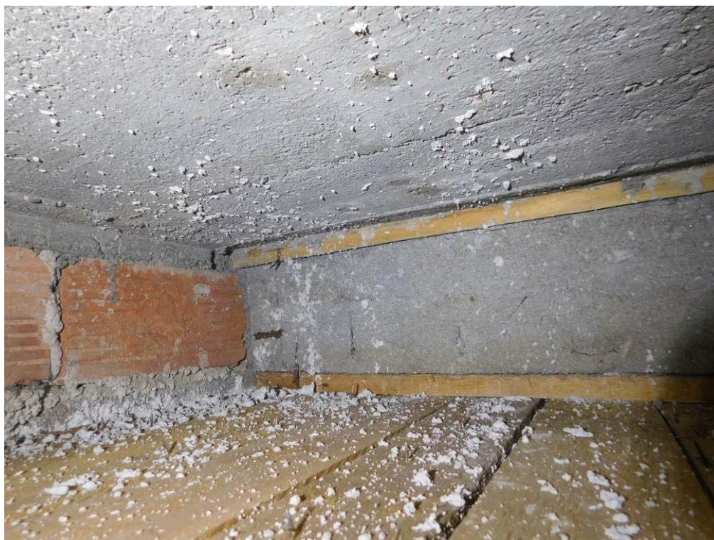
Foto 7.48. – Sonda K9 – detail - zjištěn železobetonový trémový strop s dřevěným podhledem (omítka na rákos)
