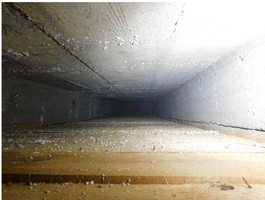
Foto 7.46. – Sonda K9 – detail - zjištěn železobetonový trámový strop s dřevěným podhledem (omítka na rákos)
