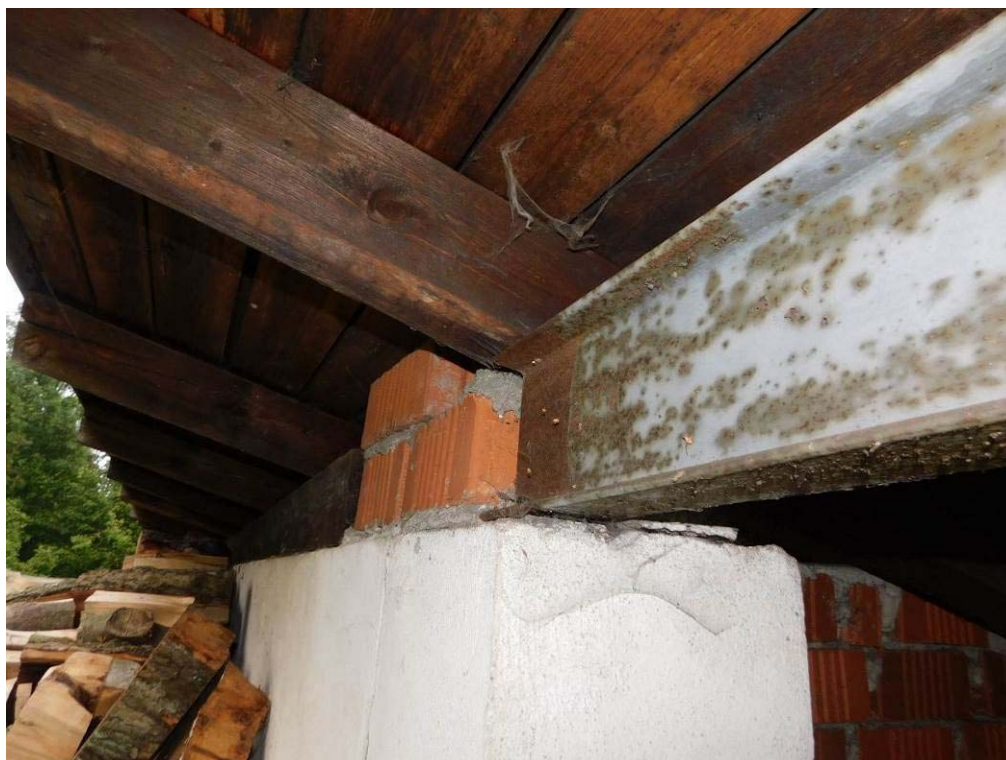
Foto 7.77. – Přístavbu na severní straně od objektu – detail pozednice na sevření straně střechy – bez viditelné koroze dřeva, z poloviny je tvořena válcovaným profilem I 160/75
