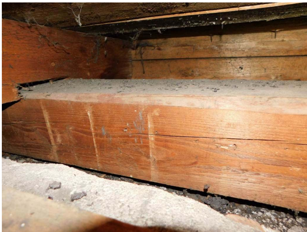
Foto 7.43. – Sonda K8 – Sonda do podhledu 2.NP (uprostřed střední části objektu, severní strana plechové střechy) – pozednice nad středovou stěnou (stěna dělicí dřevěný a betonový strop)
