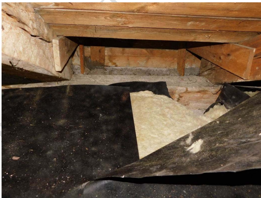
Foto 7.63. – Charakter konstrukce krovu východní části objektu (úroveň 4.NP) – sonda k pozednici – bez viditelné koroze dřeva
