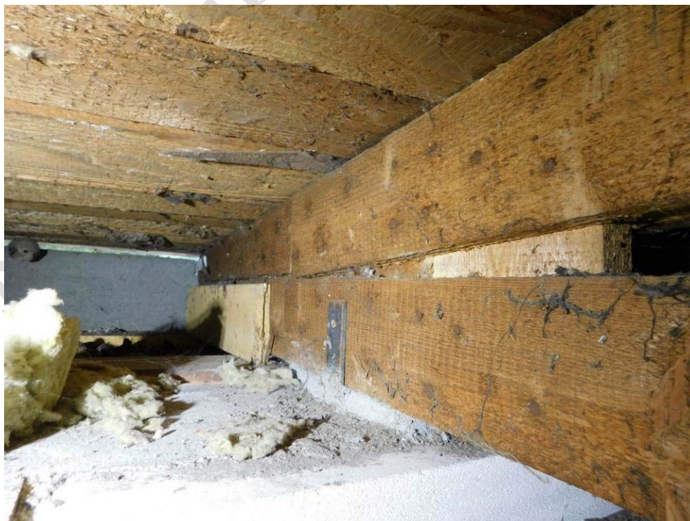
Foto 7.36. – Sonda K7 – Sonda do podhledu 2.NP – pohled směr uložení na jižní stěnu, patrný věnec z tvárníc YTONG, osová vzdálenost nosníků je 1 m
