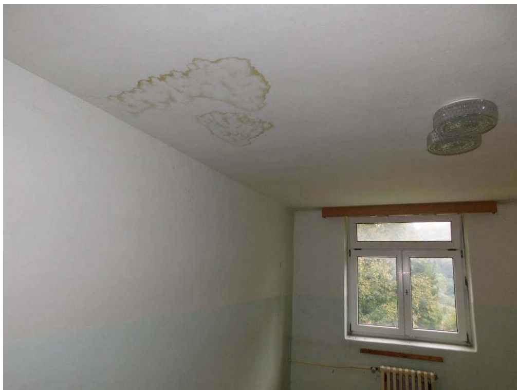
Foto 7.73. – Viditelné lokální průsaky východní části objektu (úroveň 3.NP)
