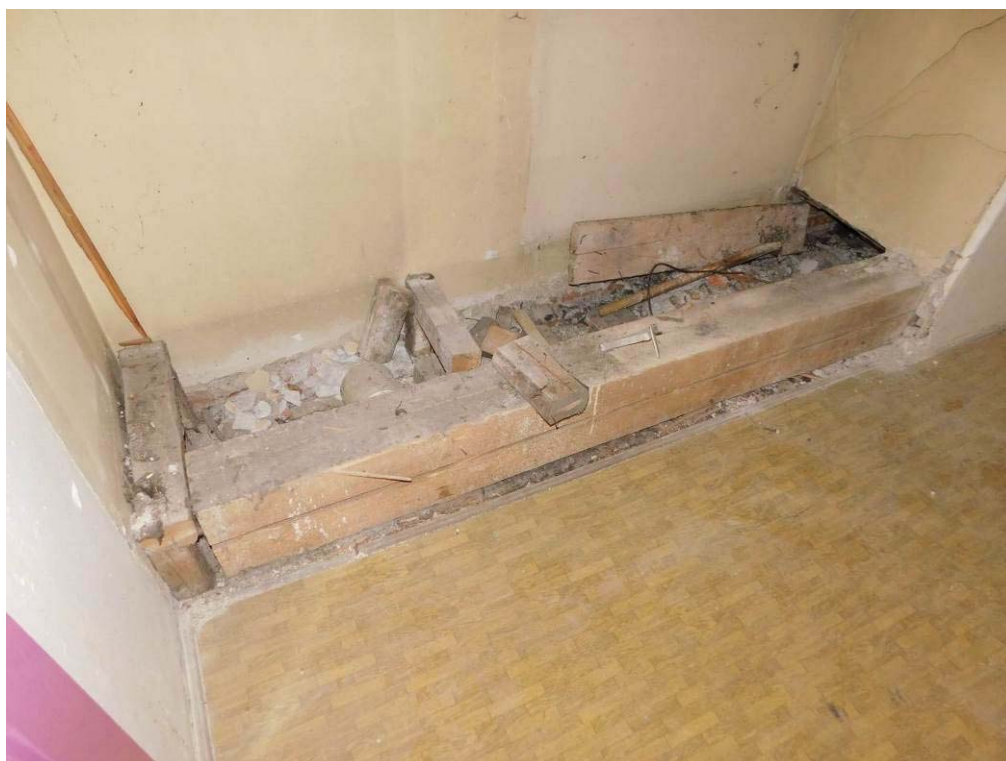
Foto 7.18. – vazný trám (úroveň 3.NP) – bez viditelných poruch či koroze dřeva
