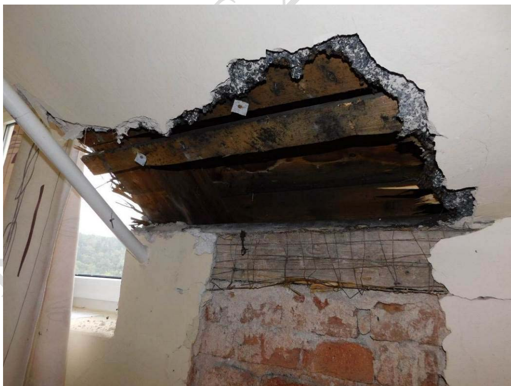
Foto 7.4. – Z část objektu - Sonda K1 (úroveň 3.NP) – pozednice a krokve – bez viditelných poruch či koroze dřeva
