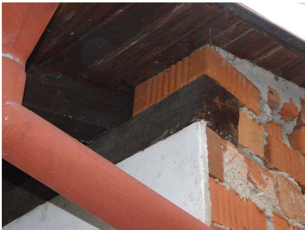
Foto 7.75. – Přístavbu na severní straně od objektu – detail pozednice na JV straně – bez viditelné koroze dřeva
