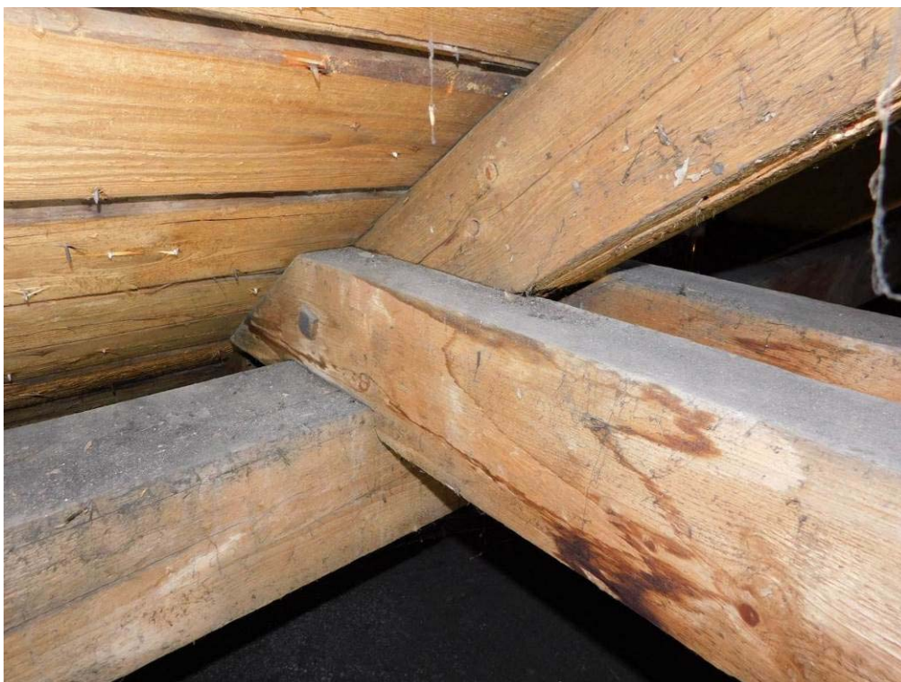
Foto 7.26. – Celkový pohled na charakter konstrukce krovu (úroveň 4.NP) – bez viditelných poruch či koroze dřeva
