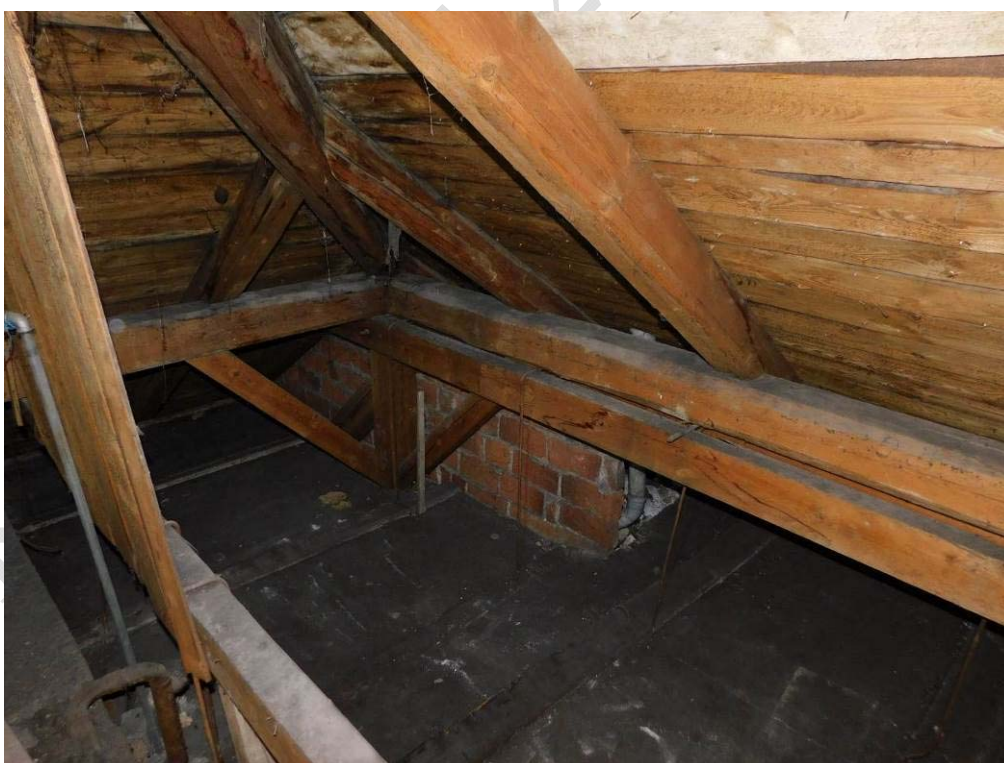
Foto 7.27. – Celkový pohled na charakter konstrukce krovu (úroveň 4.NP) – bez viditelných poruch či koroze dřeva
