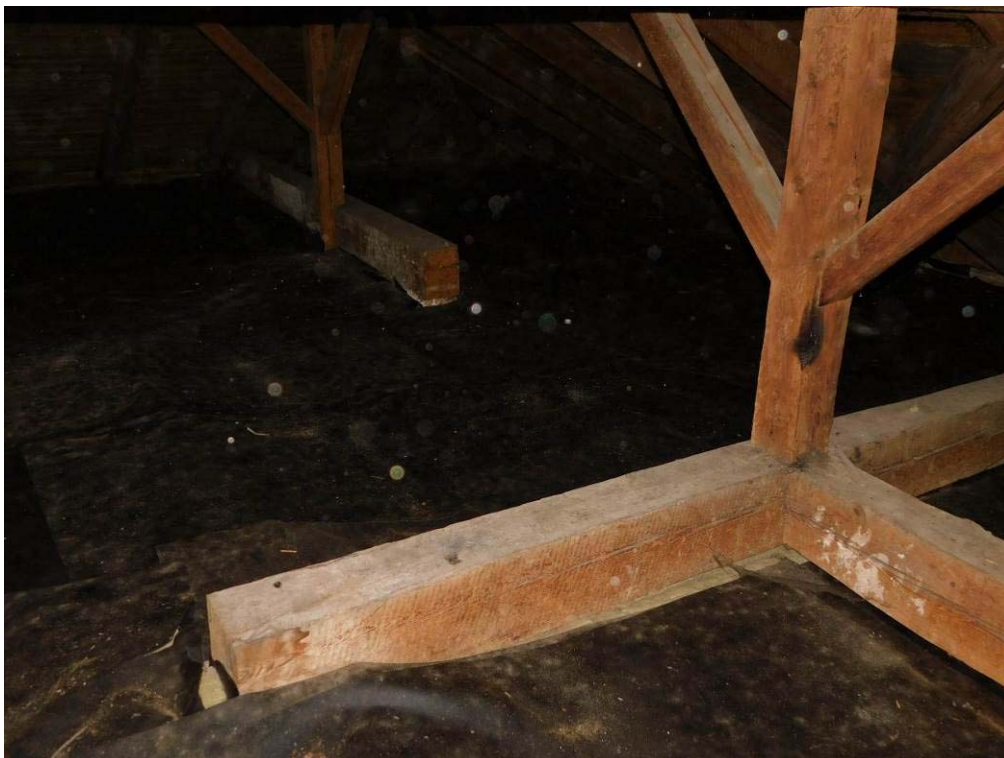
Foto 7.64. – Charakter konstrukce krovu východní části objektu (úroveň 4.NP) – bez viditelné koroze dřeva
