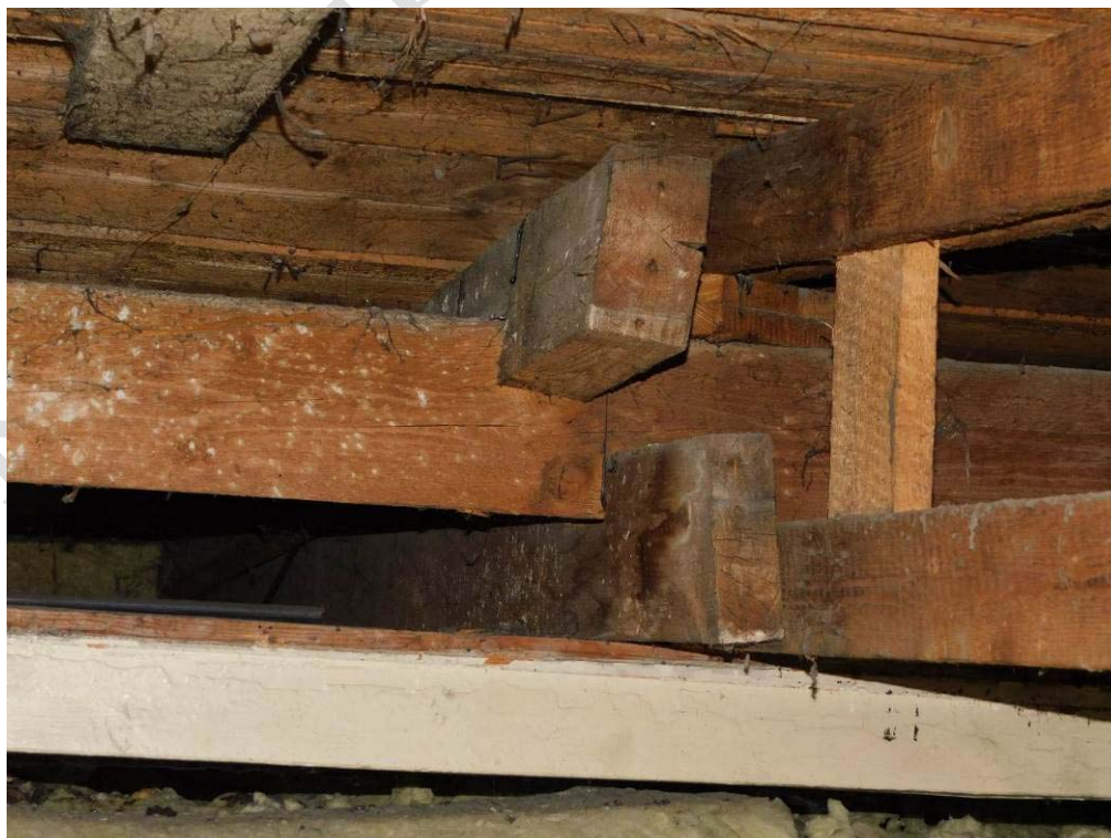
Foto 7.38. – Sonda K7 – Sonda do podhledu 2.NP – pohled směr vrcholovou vaznici v podélném směru uloženou do příčné stěny a dále na sloupek viz Foto 35
