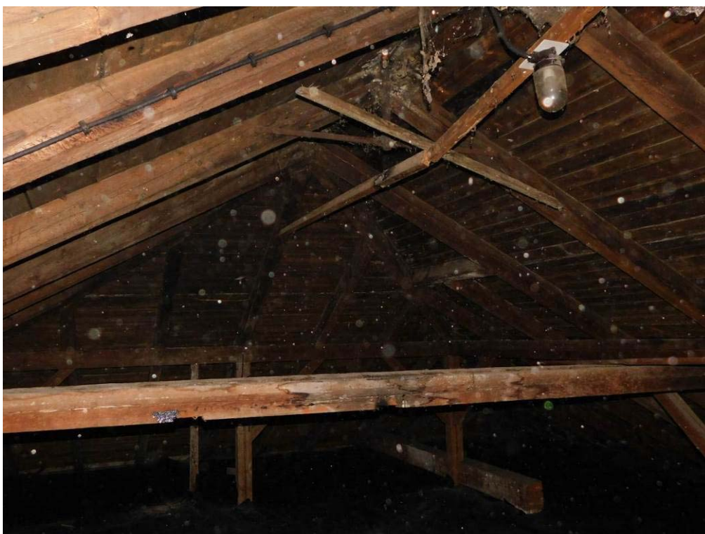
Foto 7.57. – Charakter konstrukce krovu východní části objektu (úroveň 4.NP) – bez viditelné koroze dřeva
