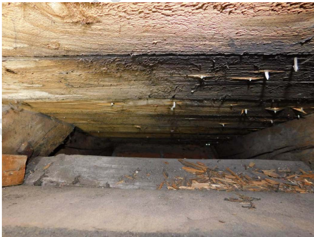
Foto 7.14. – Sonda K4 (úroveň 3.NP) – zhlaví vazného trámu – bez viditelných poruch či koroze dřeva
