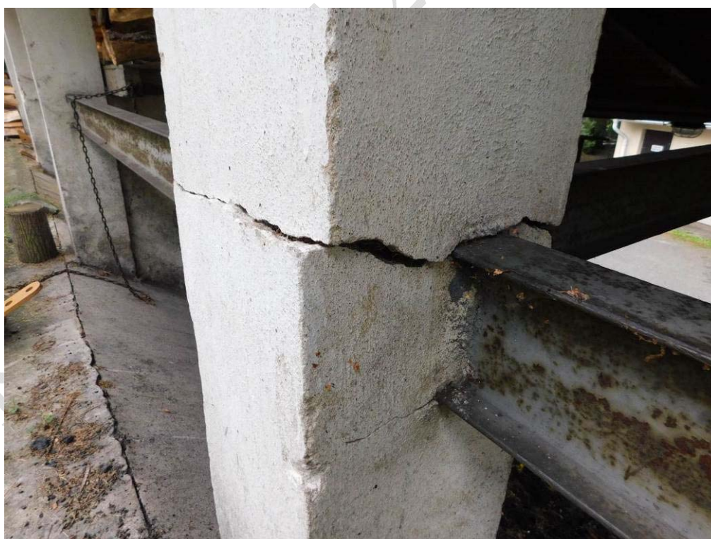
Foto 7.78. – Přístavbu na severní straně od objektu – detail typické poruchy všech sloupků
