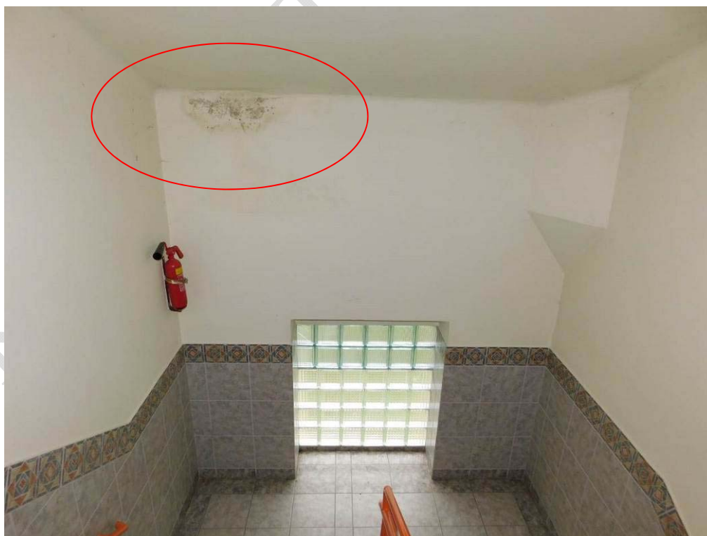
Foto 7.49. – Patrné lokální zatékání v oblasti střední části objektu
