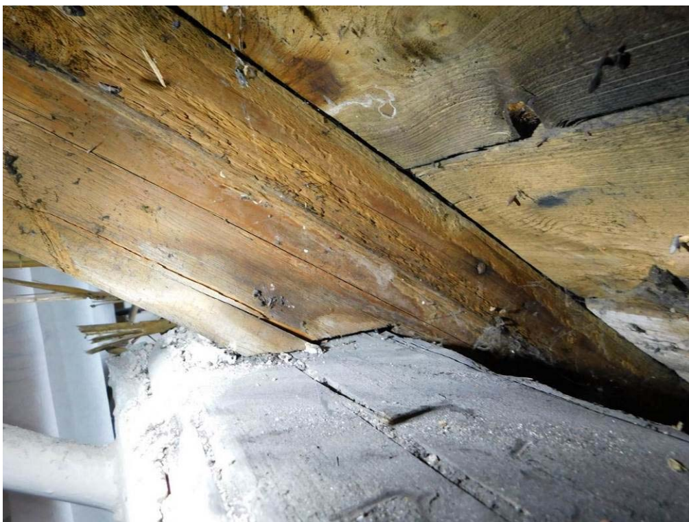
Foto 7.6. – Sonda K1 (úroveň 3.NP) – detail uložení krokve na pozednici – bez viditelných poruch či koroze dřeva
