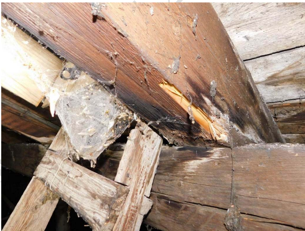
Foto 7.70. – Charakter konstrukce krovu východní části objektu (úroveň 4.NP) – odběr vzorku V5 – viditelné napadení dřeva krokve dřevokaznou houbou stupeň H1
