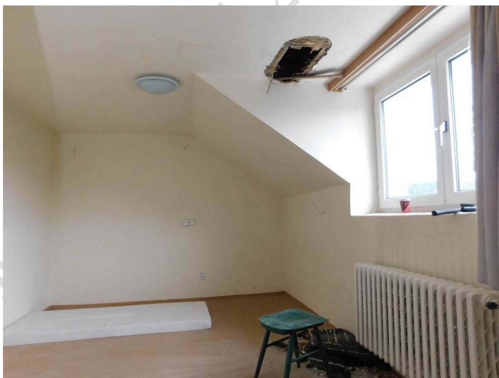
Foto 7.7. – Sonda K2 (úroveň 3.NP) – charakter konstrukce podhledu vikýře – bez viditelných poruch či koroze dřeva
