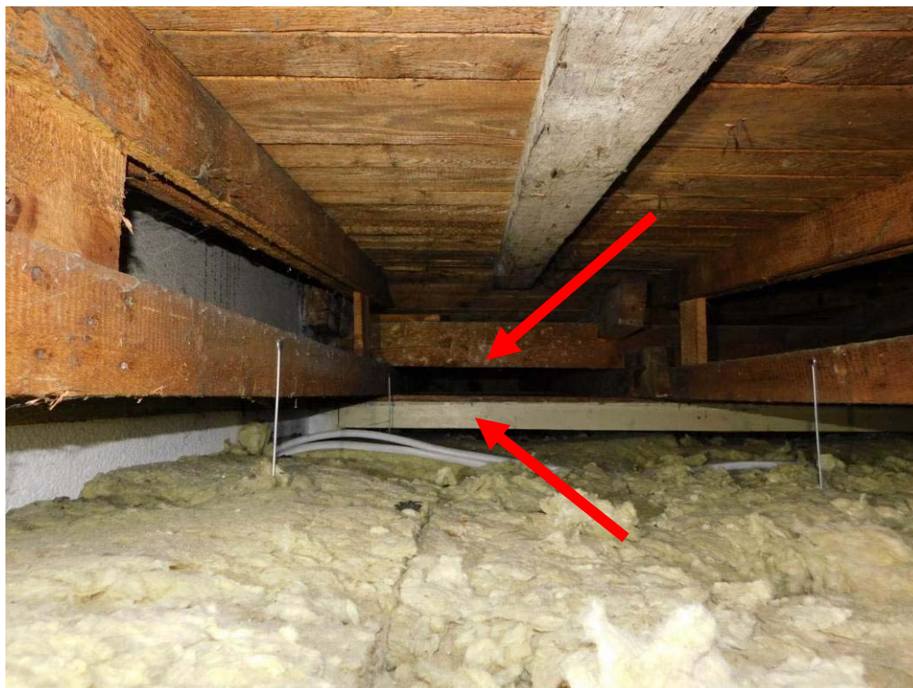
Foto 7.38. – Sonda K7 – Sonda do podhledu 2.NP – pohled směr vrcholovou vaznici v podélném směru uloženou do příčné stěny a dále na sloupek viz Foto 35
