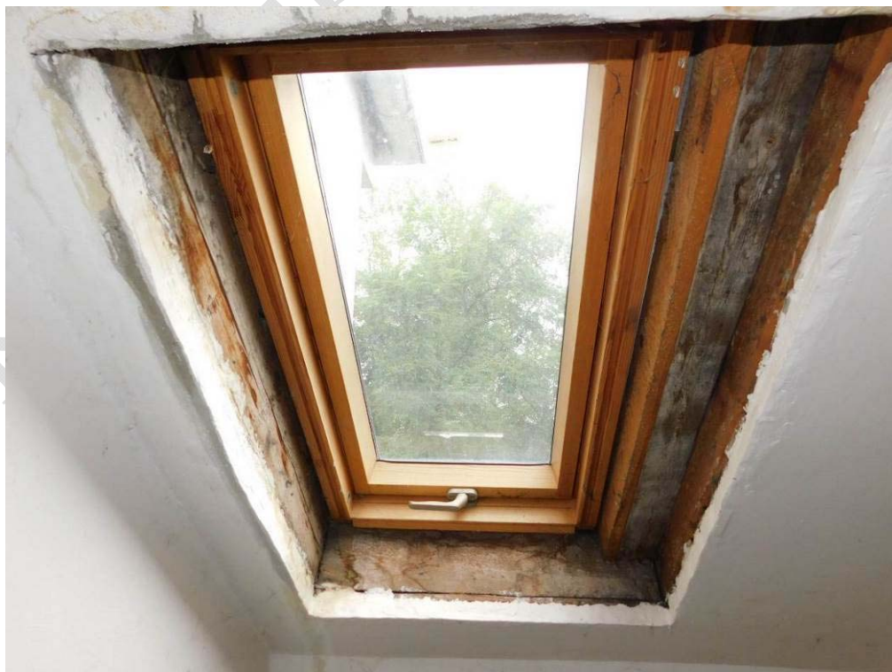
Foto 7.17. – krokve (úroveň 3.NP) – bez viditelných poruch či koroze dřeva
