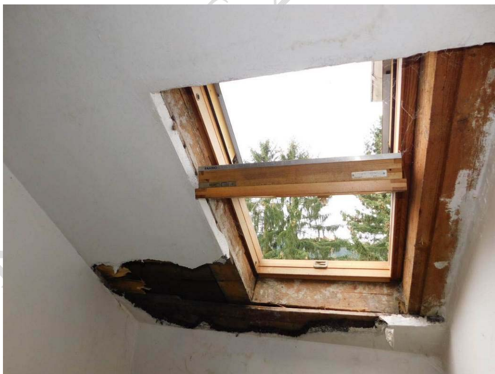
Foto 7.19. – Sonda K6 (úroveň 3.NP) – krokv a pozednice – bez viditelných poruch či koroze dřeva
