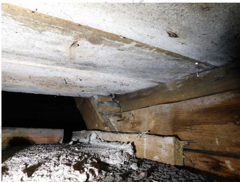
Foto 7.9. – Sonda K2 (úroveň 3.NP) – charakter konstrukce podhledu vikýře – bez viditelných poruch či koroze dřeva
