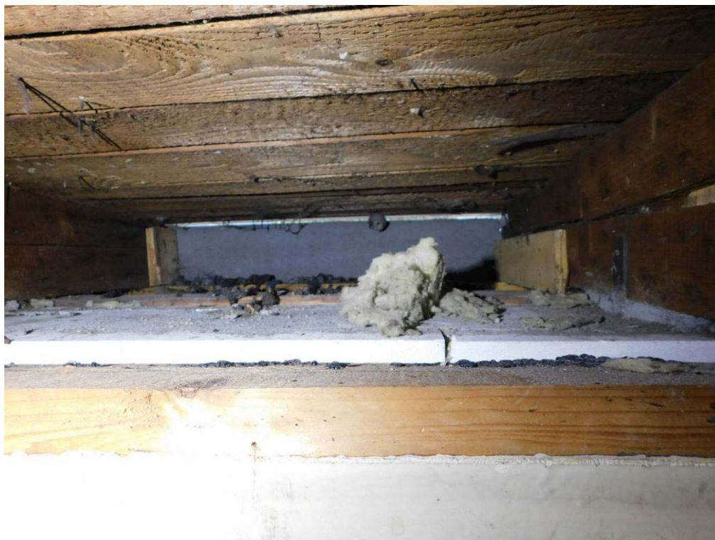
Foto 7.36. – Sonda K7 – Sonda do podhledu 2.NP – pohled směr uložení na jižní stěnu, patrný věnec z tvárníc YTONG, osová vzdálenost nosníků je 1 m
