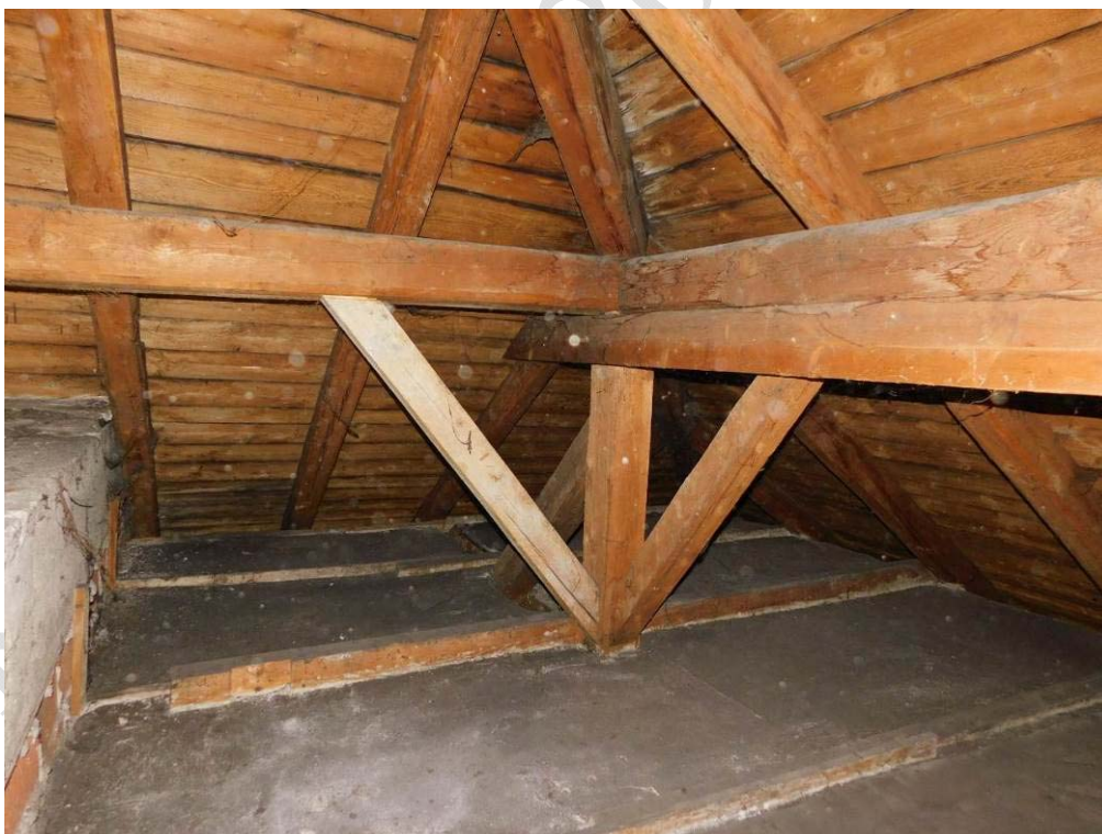
Foto 7.23. – Celkový pohled na charakter konstrukce krovu (úroveň 4.NP) – bez viditelných poruch či koroze dřeva
