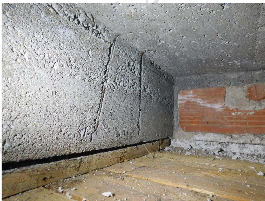
Foto 7.47. – Sonda K9 – detail - zjištěn železobetonový trámový strop s dřevěným podhledem (omítka na rákos)
