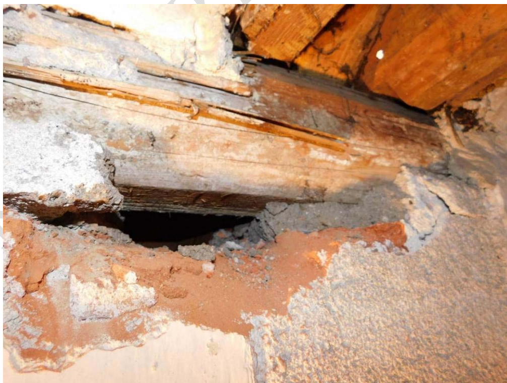
Foto 7.11. – Sonda K3 (úroveň 3.NP) – pozednice – bez viditelných poruch či koroze dřeva
