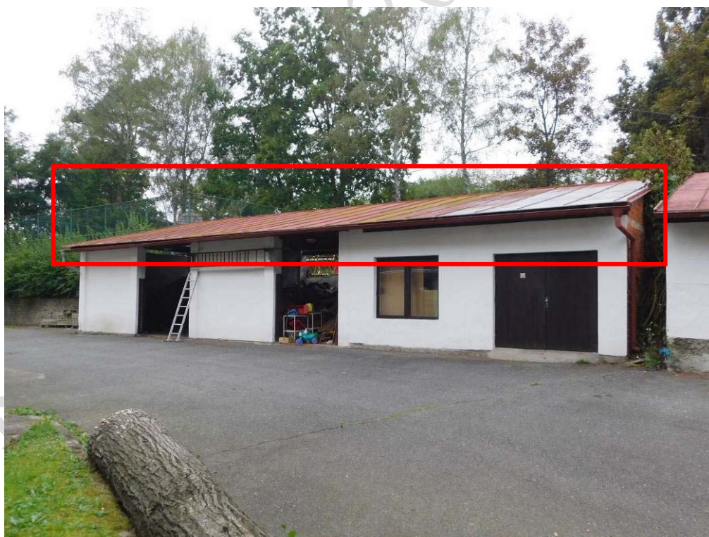
Foto 7.74. – Celkový pohled na přístavbu na severní straně od objektu – vyznačena sledovaná část konstrukce střechy, pohled jižní – bez viditelné koroze dřeva
