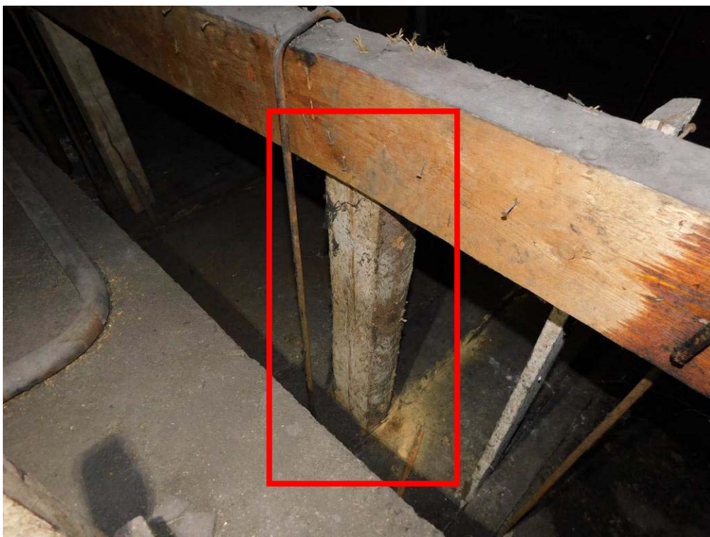
Foto 7.30. – Celkový pohled na charakter konstrukce krovu (úroveň 4.NP) – podpůrný sloupek vazného trámu – viditelná koroze dřeva stupeň DH2 – doporučujeme úplnou výměnu prvku
